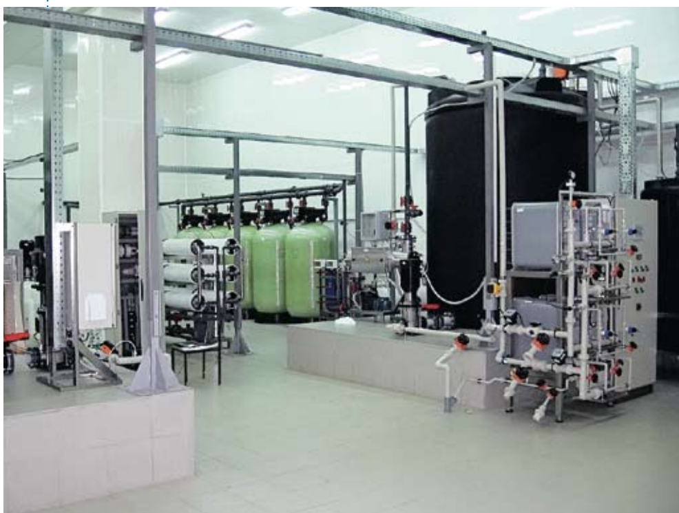
■ Системы предварительной подготовки воды на основе автоматических фильтров механической очистки, удаления железа и марганца, умягчения, дехлорирования, серии «Акватон»
