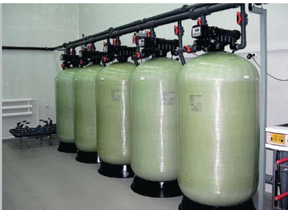
■ Системы предварительной подготовки воды на основе автоматических фильтров механической очистки, удаления железа и марганца, умягчения, дехлорирования, серии «Акватон»
